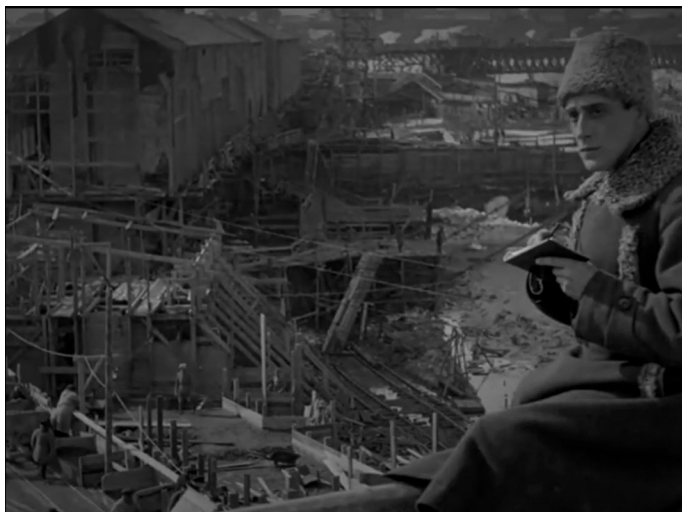
Рис. 2. Инженер Лось на стройке. Кадр из фильма «Аэлита», реж. Я. Протазанов, 1924. 00:43:09. Скриншот автора
